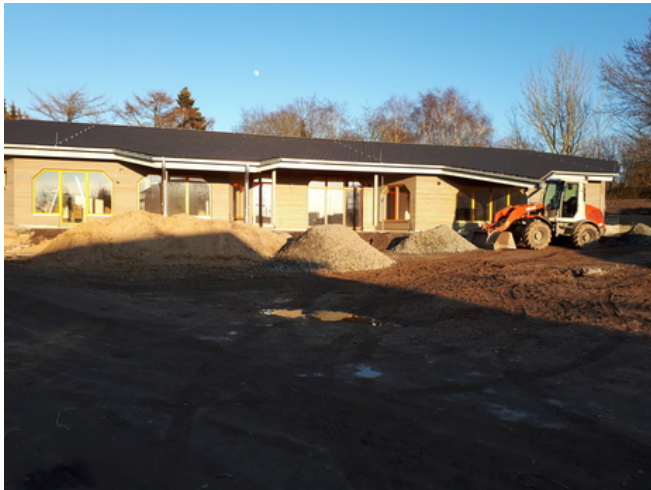
Drei Wochen vor der Eröffnung ist noch viel zu tun. Das Außengelände ist noch nicht begeh- und bespielbar.
