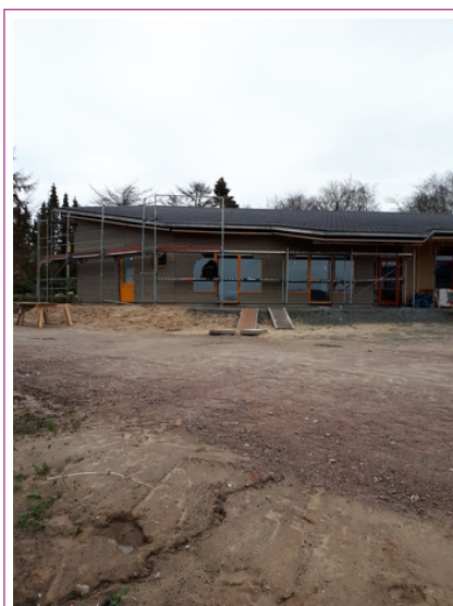
Der Waldorfkindergarten im Februar kurz nach dem Richtfest.
