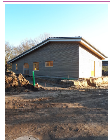
Der Haupteingang des Kindergartens rund drei Wochen vor der Eröffnung.
